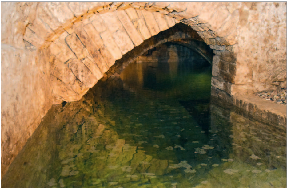
Unterirdischer See im Gewölbekeller der Königsborn-Brauerei in Finthen.
