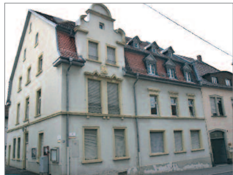
Das alte Rathaus, Poststraße 69.
